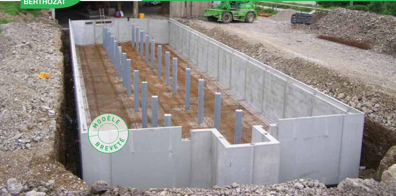
**IDÉAL POUR LA CONSTRUCTION RAPIDE DE FOSSE À LISIER.** UN SYSTÈME DE CLAVETAGE ET DE LIAISON AVEC RADIER ET JOINTOIEMENT PERMET D'AVOIR UN AGRÈMENT SUR L'ÉTANCHÉITÉ. TOUS LES CHANTIERS SONT RÉALISÉS SUR MESURE ET UNE ÉTUDE BÉTON EST FAITE AU PRÉALABLE.
